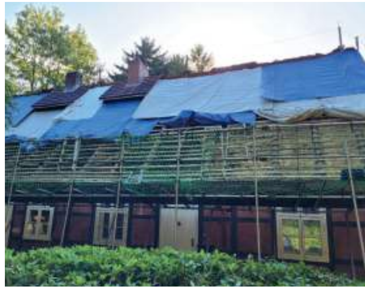
Dacharbeiten am Sinstorfer Küsterhaus
